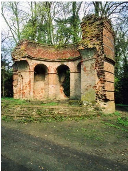
Abb. 5 Prillwitz, Mausoleumsruine im Park östlich des Schlosses, April 2006. Fotografie: Detlef Schnell.
