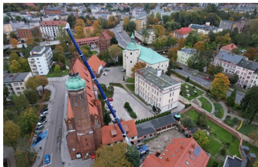
Abb. 5 und 6 Demontage des Turmhelms. Fotografie: Rafał Jeka.
